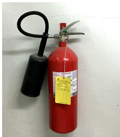
ภาพที่ 1-15 ถังดับเพลิงแบบมือถือ
